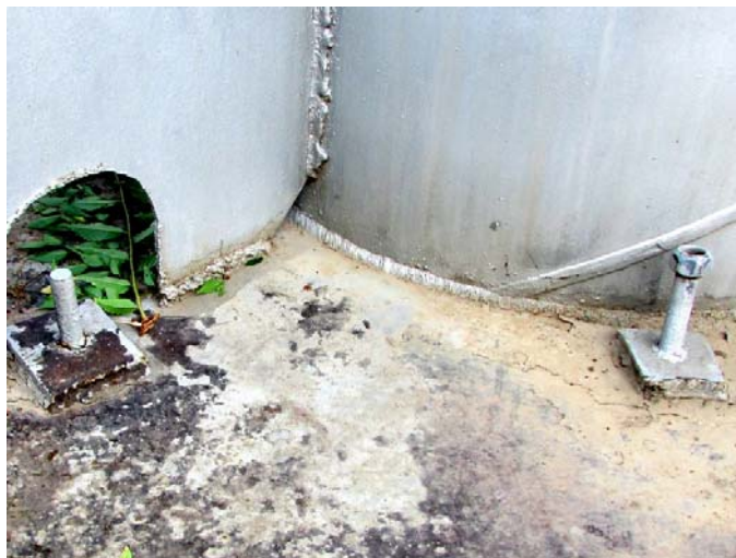
Рисунок 5 - Отсутствие гаек на анкерных болтах
