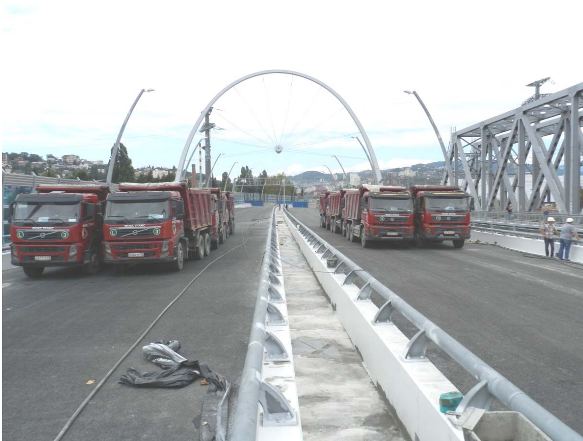
Рисунок 2 – Вид от начала моста. Загружение пролетного строения испытательной нагрузкой.
