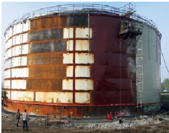
Рисунок 1- Процесс восстановления антикоррозионного покрытия.
