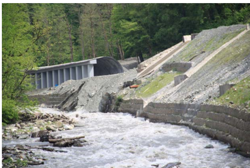
Рис. 3 – Селезащитная галерея и сброс селевых масс в русло р. Мзымта, фото автора, май 2017 г.
