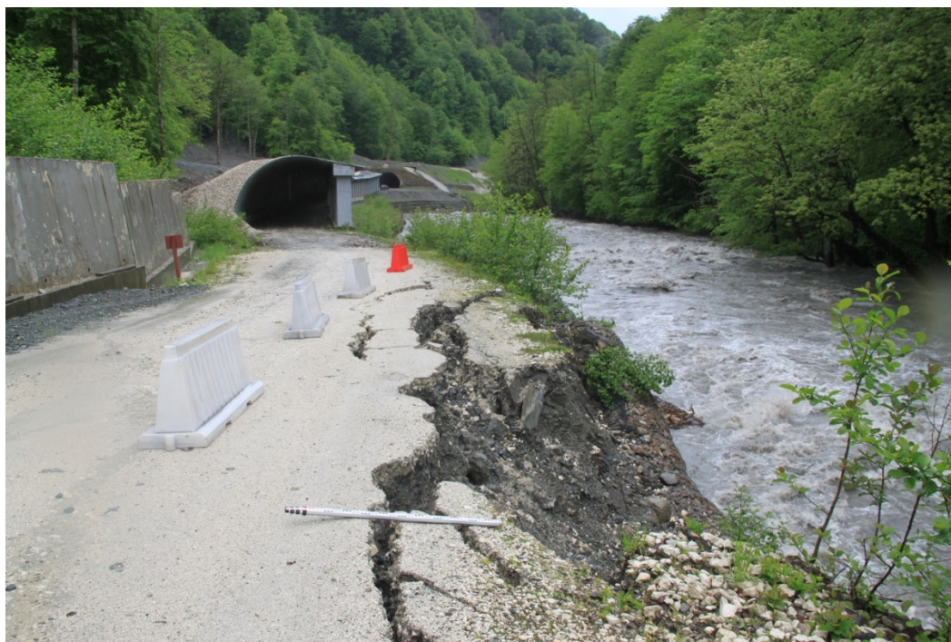
Рисунок 6 – Оползень № 2 вызванный боковой эрозией на дороге № 23 горного курорта «Роза – Хутор» в мае 2017 (фото автора).
