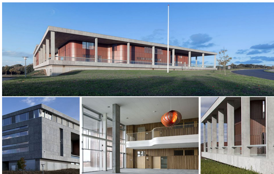
Рис 3. Здание Верховного суда Западной Дании в Виборге
