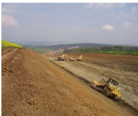
Рисунок 1 – Работа грейдера на откосе [5].
