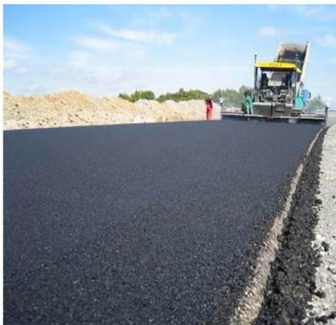
Рисунок 3 – Укладка асфальта [5].
