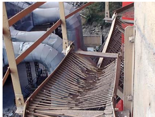
Рисунок 2 – Обрыв щита настила светофорной площадки падающим гололёдом
