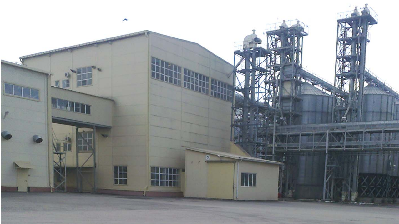
Рисунок 9 – Здание рисо завода
