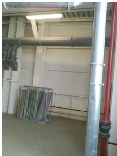
боковая часть, 2 этаж
