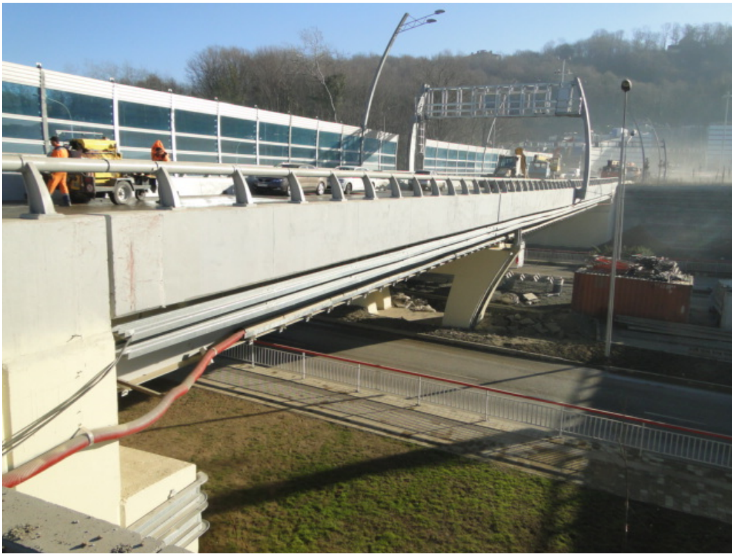
Рисунок 1 – Вид с левой стороны от конца путепровода. Общий вид путепровода по фасаду.
