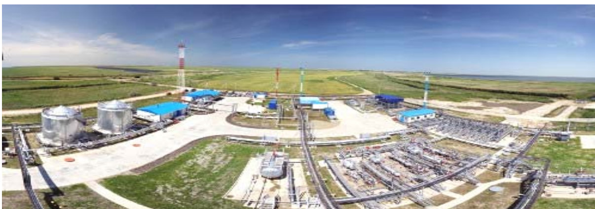
Рисунок 2 - Установка подготовки газа в Славянском районе Краснодарского края
