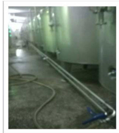
Рис. 16 - Система для промывки емкостей
