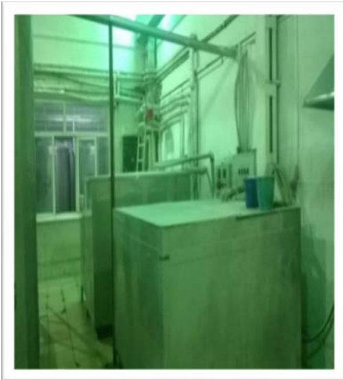
Рис. 11 - Емкость для хранения пропиленгликоля
