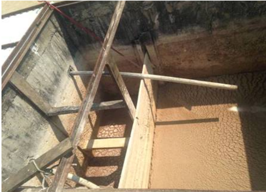
Рисунок 3 – Площадка для обезвоживания шлама
