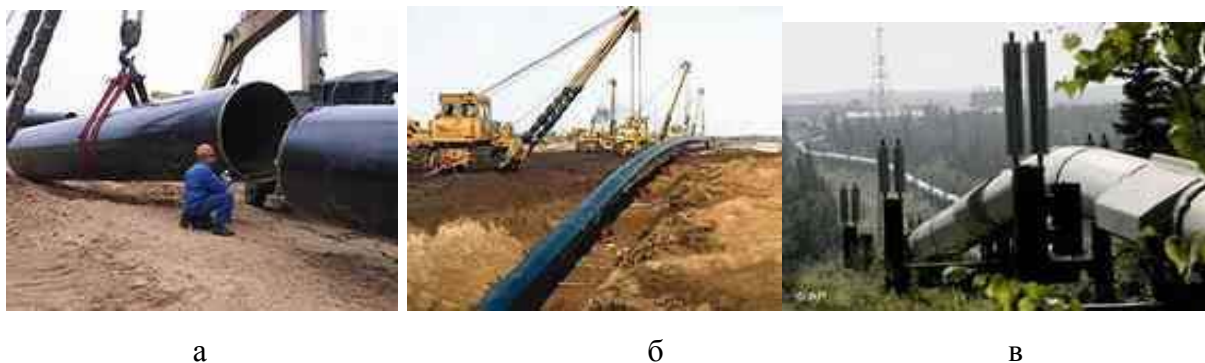
Рисунок 1. Магистральный нефтепровод : а, б, – монтаж МН; в – эксплуатация МН.
