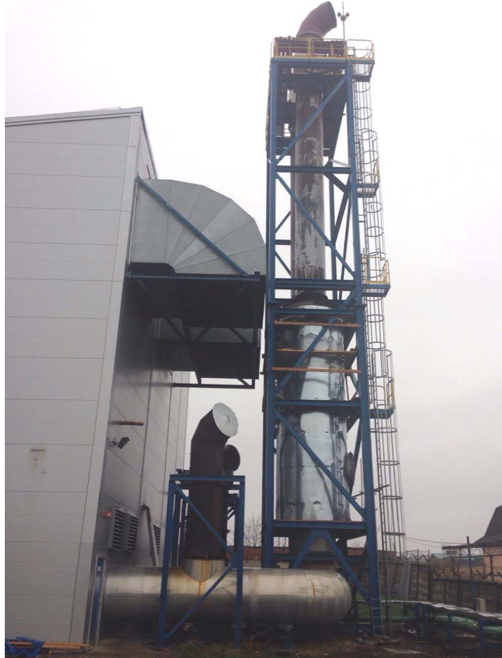
Рисунок 3 – Шумоглушитель на Ейской ТЭС.
